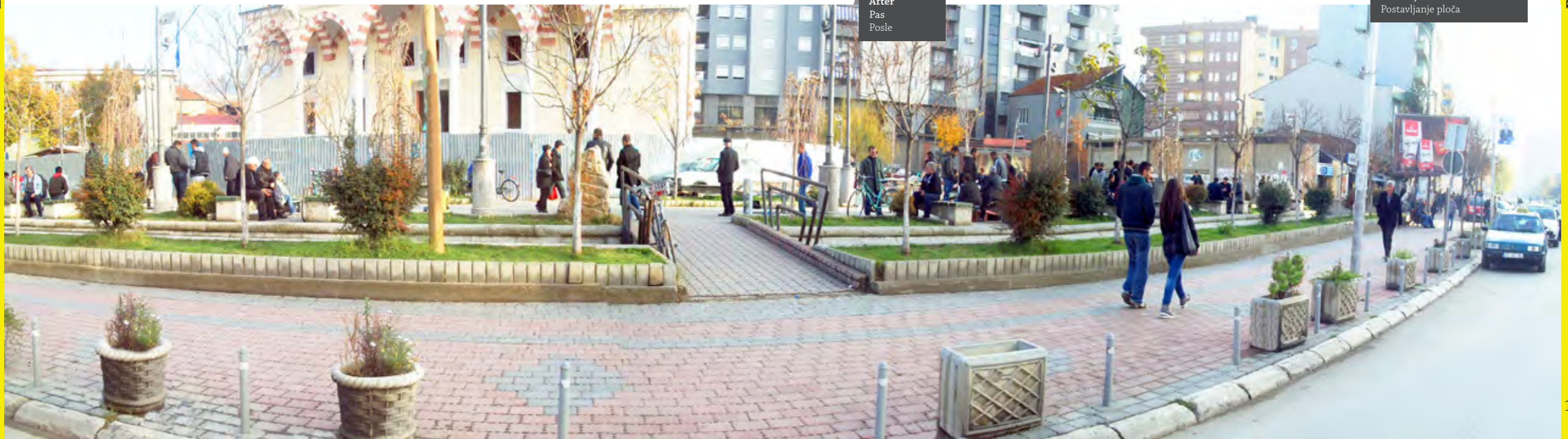
Installation of cobblestones Vendosja e kubëzave Postavljanje ploča
