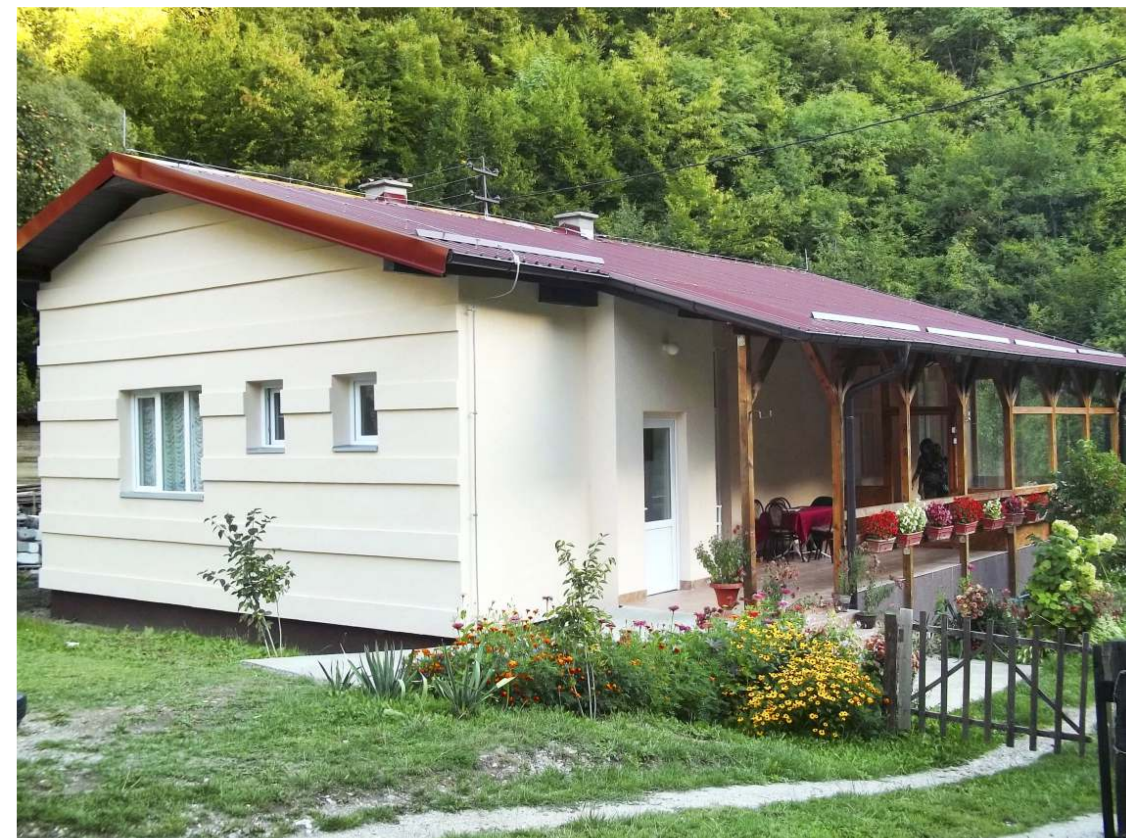
Health centre after EU-BK intervention - August 2013 Дом здравља након ЕУ-ЛК интервенције - август 2013
